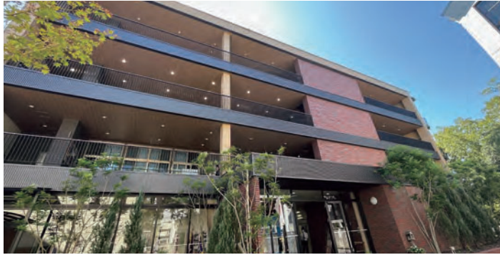
7号館(清秀棟) 岡山学芸館清秀中学校・高等部の専用棟。明るい笑顔と活気で溢れています。
